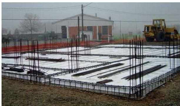
I pannelli di questa serie sono costituiti unicamente da EPS quindi non autoportanti, essi vengono messi in opera come solai sanitari al piano terra, appoggiati su un letto di sabbia o come solai sovrapposti a strutture esistenti da sostituire. In entrambi i casi si sfrutta la leggerezza dell'elemento Plastbau® Metal sia a vantaggio della maneggevolezza in cantiere che della coibentazione senza ponti termici.
