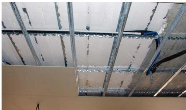
I pannelli di questa serie sono privi di rete metallica in quanto destinati ad essere lasciati grezzi, rivestiti con placcature montate a secco, o controsoffittati sfruttando i lamierini inglobati nel pannello ad interasse cm 30.
