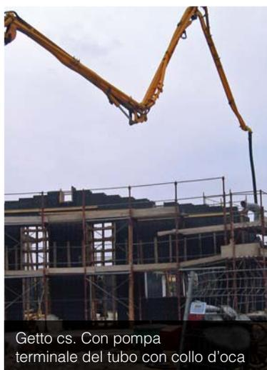
Getto cs. Con pompa terminale del tubo con collo d'oca
